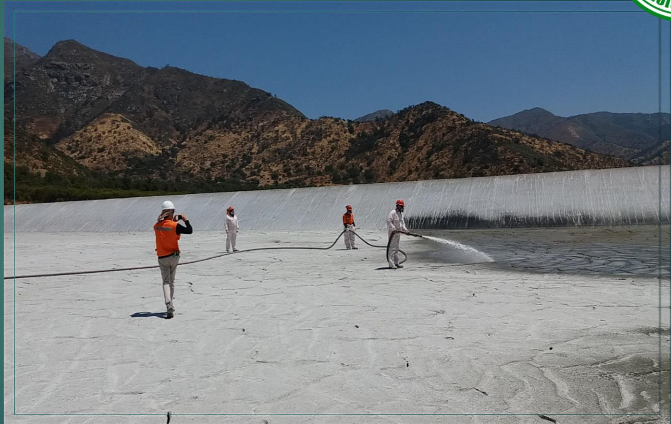
Cobertura de relave: Camión aljibe y mangueras
